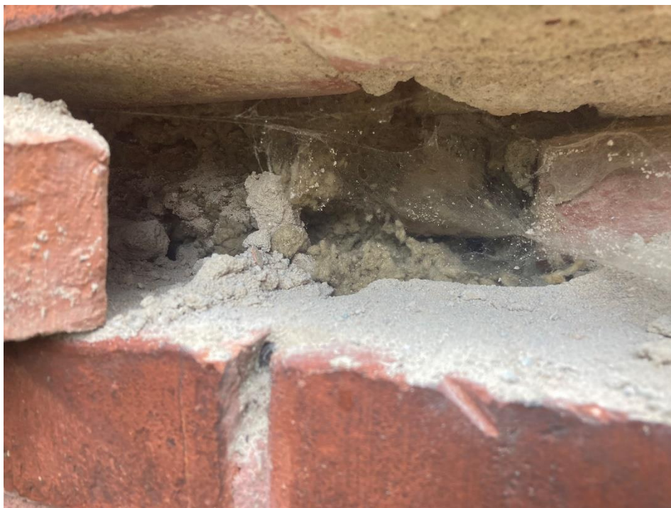
Foto 12. På ét enkelt hus er det observeret, at murværket er isoleret med ca. 5cm isoleringsmateriale
